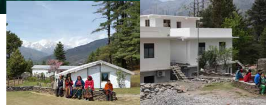
Das Phaplu-Hospital vor (links) und nach (rechts) dem Erdbeben.
